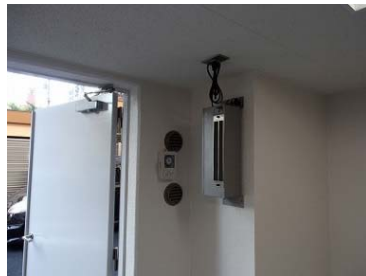
給気が壁面の場合の取付例
