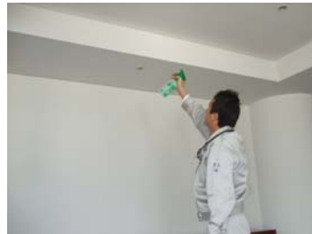
▲仕切り壁周辺にトレーサガスを噴霧
