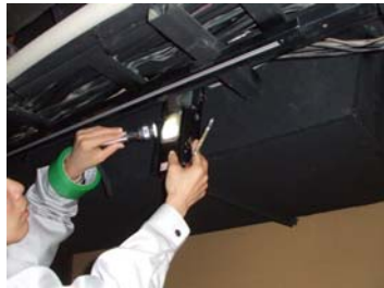
▲ダクトの接続部をセンサーで測定
