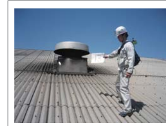
工場排気口調査
