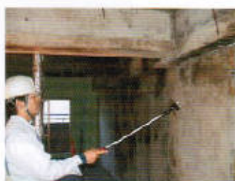
消臭剤 噴霧作業
