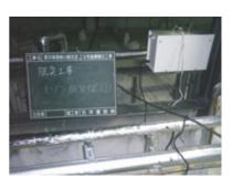
・ 状況:倉庫内で火災発生し、倉庫内が燃え屋根裏にもススが全体に広がりました。オゾン生成装置は酸素ガスを 使用する高濃度タイプを複数使用し、超高分子薬剤も数度にわたり噴霧して臭気を低減しました。面積が 膨大なため、10日間の脱臭工事となりました。
