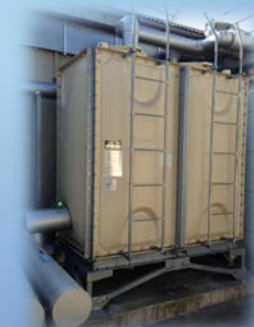
チラーユニット タンクへの投入
